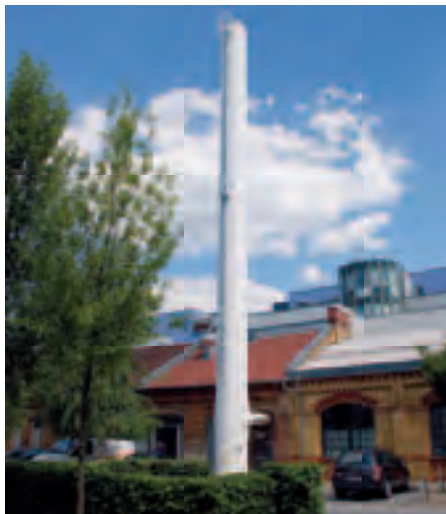
Zur Absicherung von Havariefällen und zur Deckung von Spitzenlasten bleiben die bis dahin genutzten Kesselanlagen auf dem Volltuchgelände erhalten.
