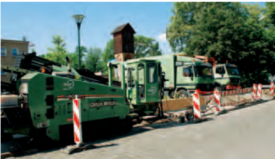
Eine Spülbohrmaschine schuf damit zielgenau die unterirdische Verbindung.
